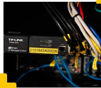
Коммутаторы T2700G-28TQ выступали в качестве коммутаторов уровня ядра, два uplink-порта 10G на каждом коммутаторе использовались для подключения оборудования производственных команд в пункте управления, монтажной и EVS, а также для трафика прессы, партнёров, тренировочной зоны, зоны соревнований и сцены.
